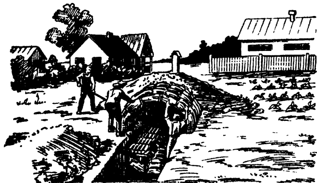
Рис. 9. Устройство противорадиационного укрытия из кольцевых фашин
